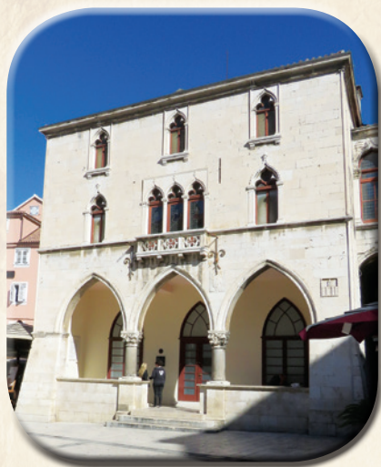
Zgrada Stare gradske vijećnice na Pjaci
